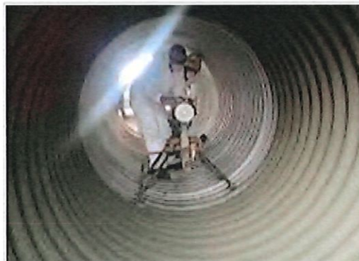
Figura 8.4. Revestimiento centrifugado de concreto para reparar tubos pluviales defectuosos. Se muestra el aplicador (spincaster).
