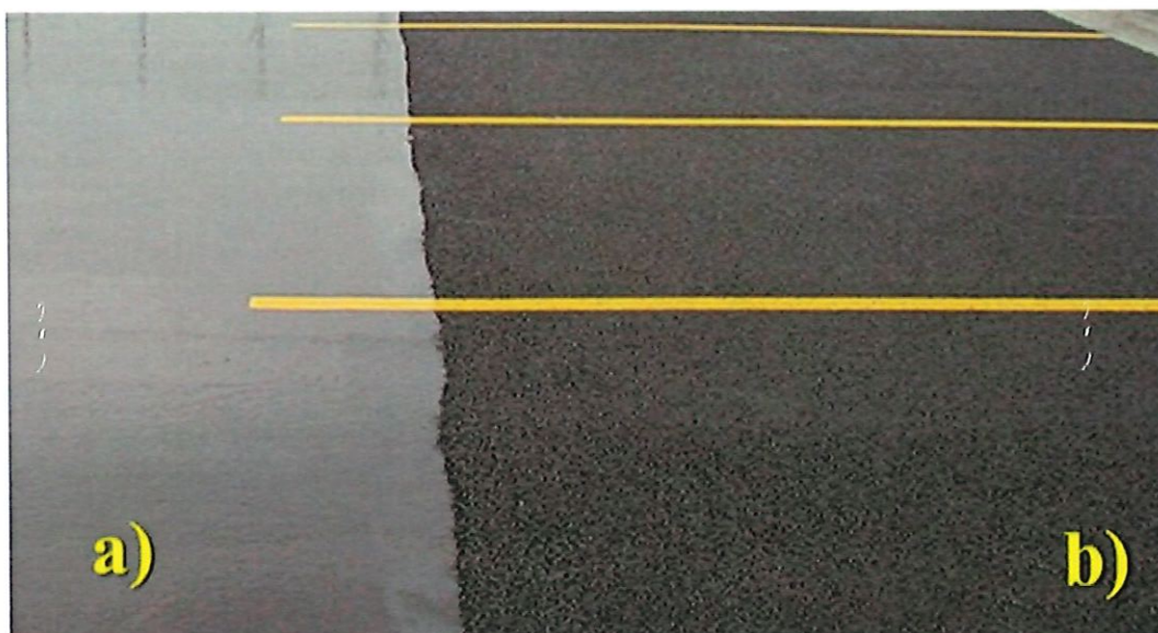
Figura 10.21 Comparación entre asfaltos poroso y convencional en un área de estacionamiento para vehículos. A) Asfalto convencional. Nótese la capa de agua depositada sobre el pavimento. B) Asfalto poroso. No acumula agua en la superficie.
