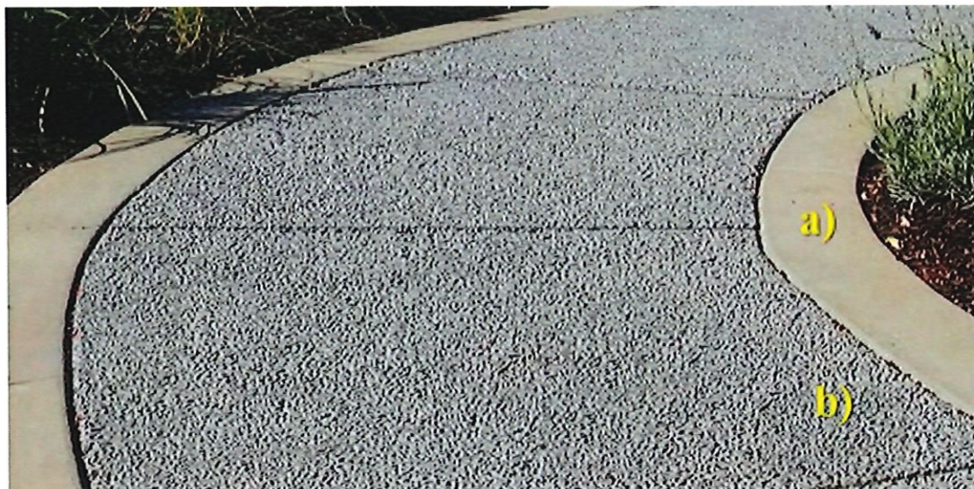
Figura 10.22 Hormigón poroso para aceras o rampa para vehículos. a) hormigón convencional, b) hormigón poroso.
