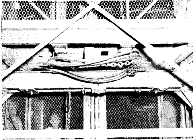
Fig. 45:- Vista demostrando una percha para almacenar cable adicional de reposición para el cable de control eléctrico.
