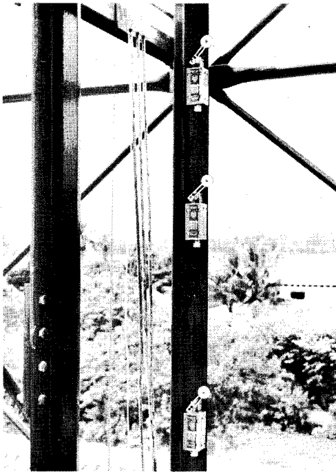
Fig. 38:- Vista de un tipo de interruptor de velocidad, los cuales están localizados en el extremo alto y bajo de la torre de manera que automáticamente controlen la velocidad y detengan el carro. Cuando la leva en el carro toque el brazo del primer interruptor, la velocidad del carro se reduce a una baja velocidad. Cuando se toca el segundo interruptor el carro se detiene automáticamente. El tercer interruptor es de límite final y se usa solamente como una precaución adicional de seguridad para el caso en que los anteriores no funcionen.
